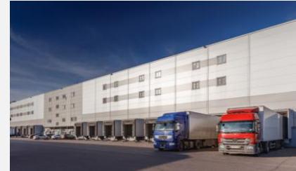
Адмирал 108 тыс. кв. м / 7-8 млрд руб. Санкт-Петербург Сбережения Плюс
