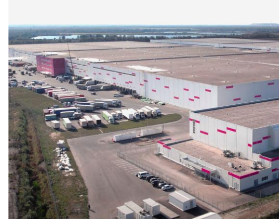
III очередь WB Электросталь 105 тыс. кв. м
