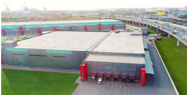
“特罗伊茨基物流工业园” 仓库综合体圣堡
