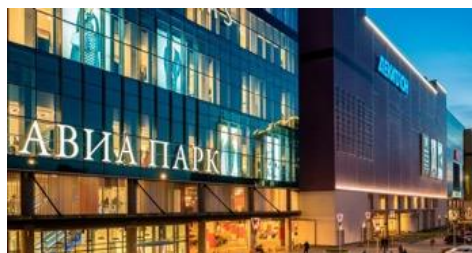
Aviapark 住宅小区
